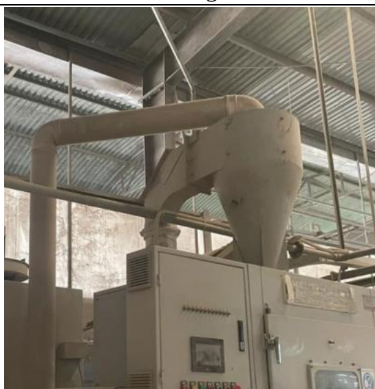
Chi tiết thiết bị Cyclone
