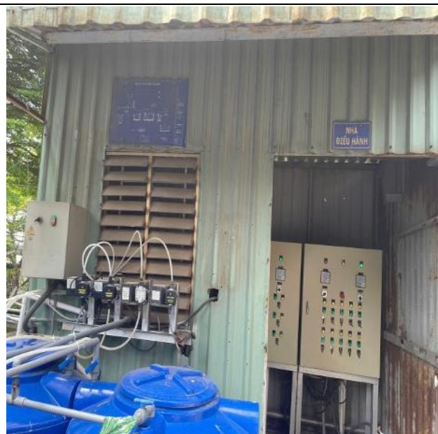
Khu vực nhà điều hành
