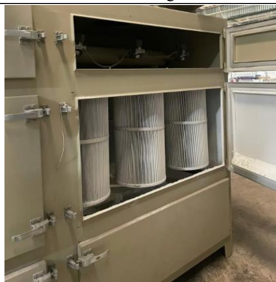
Chi tiết thiết bị lõi lọc cartridge
