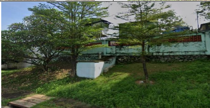
01 Hố ga đầu nối nước thải với KCN
