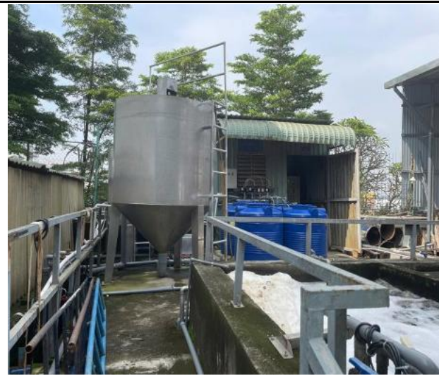
Hình ảnh hệ thống xử lý nước thải công suất 50 m 3 /ngày.
