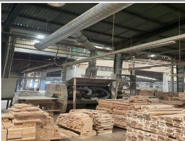
Hệ thống chụp hút, đường ống thu gom bụi về hệ thống xử lý
